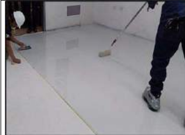
Rodillo Expandir sor y zapatos con púas
