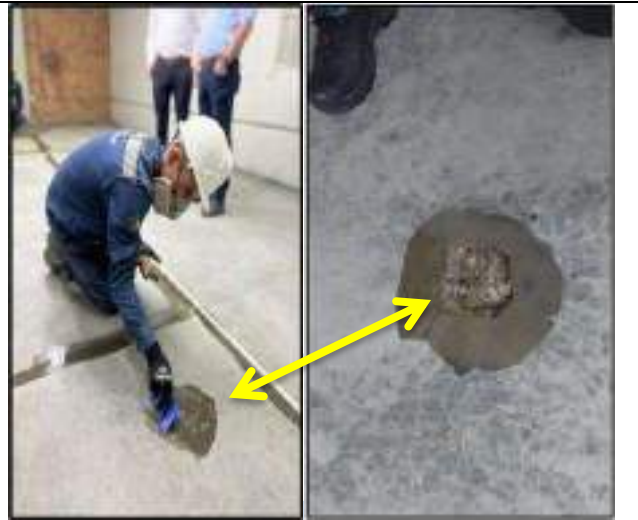
Aplicación Flooring104+carga (cab-o-sil) Zona de Hueco
