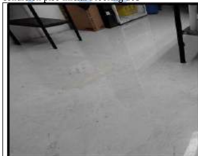
condición piso inicial Flooring 105
