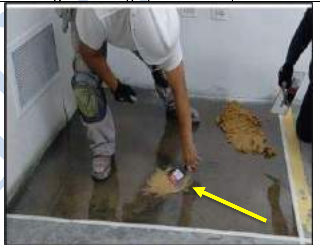
Nuevamente Relleno de Hueco Flooring 104 + carga (Arena Silice)
