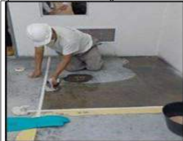
Aplicación con Llana Flooring 104
