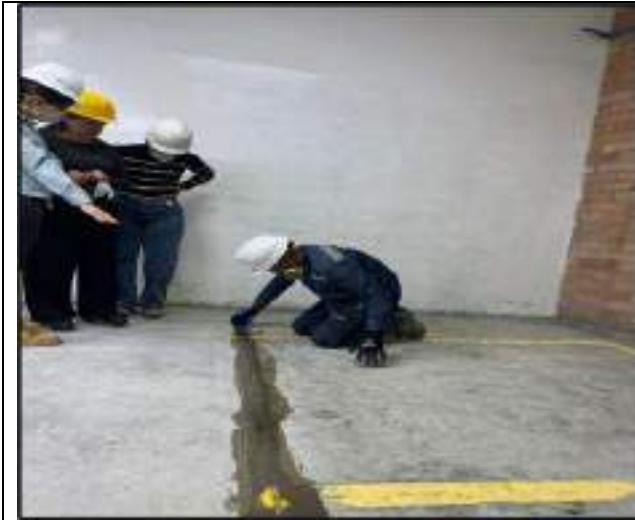
Aplicación Flooring 104 + carga (cab-o-sil) Zona Unión de Placa
