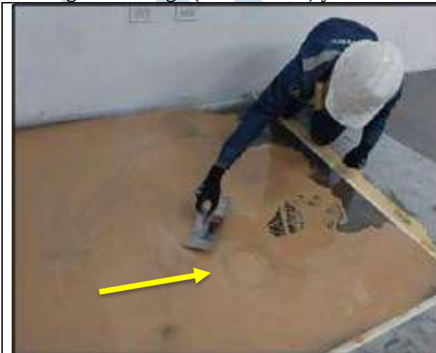
Tratamiento Zona de Huecos Flooring 104 + carga (Arena Silice) y
